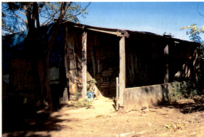
Figura 3. Ocupação às margens da BR070
